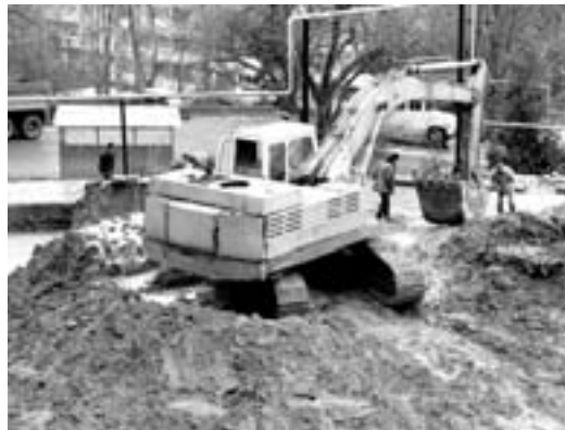
НА СНИМКЕ: (вверху слева направо) Виктор Ширяев, Леонид Попов и Василий Павлюк на котловане будущего дома для ветеранов.
